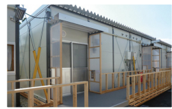
応急仮設住宅
