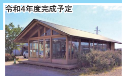
小森仮設団地B棟みんなの家
