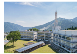
旧東海大学阿蘇校舎1号館・地表地震断層
