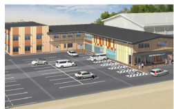
松橋東防災拠点センター
