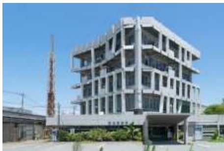
被災した旧宇土市役所
